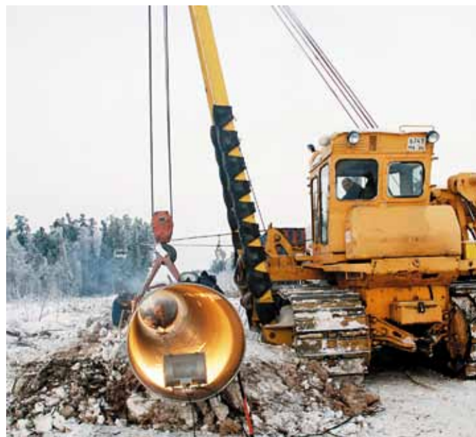
Своевременный ремонт — основа надёжности магистрали
